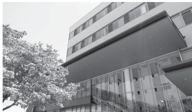
エントランス部分はガラス張りで開放感のある作りに
