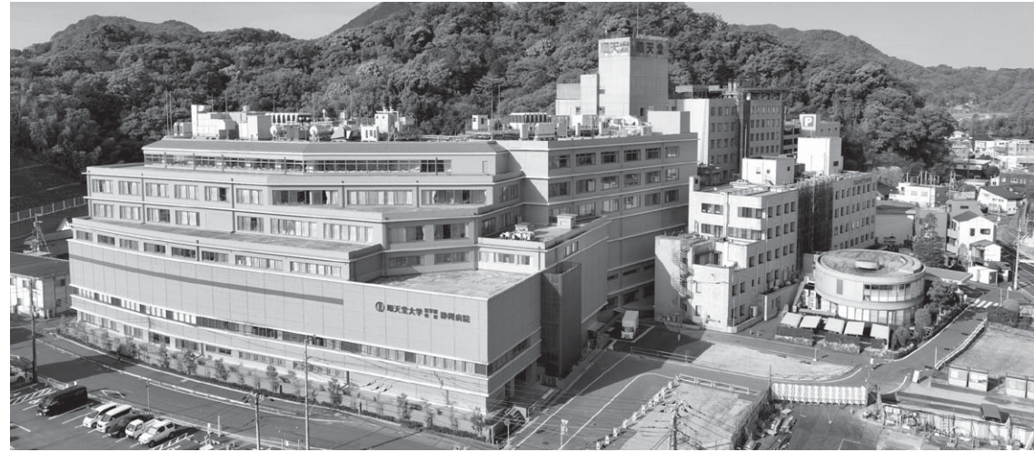
竣工したH棟（写真左）
