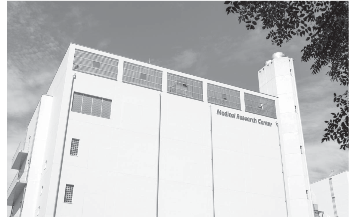
メディカルリサーチセンター外観
